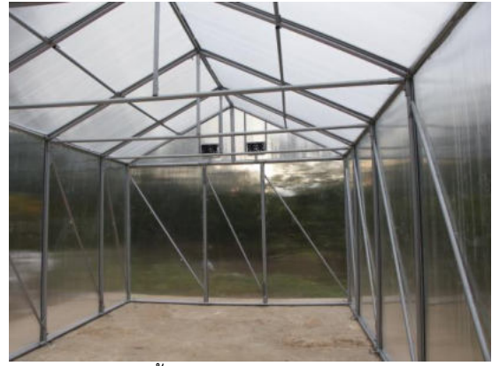
(ง) การติดตั้งพัดลมบังคับการไหลของอากาศ
