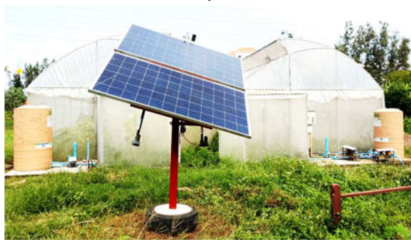
ภาพที่ 1 ระบบผลิตไฟฟ้าเซลล์แสงอาทิตย์แบบติดตามดวงอาทิตย์สองแกน ขนาด 600 วัตต์
