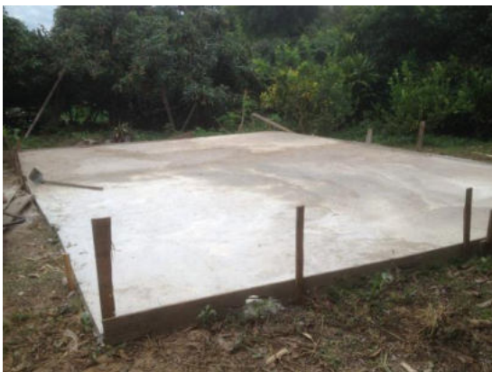
(ก) การเทพื้นคอนกรีตสำหรับใช้เป็นฐาน
